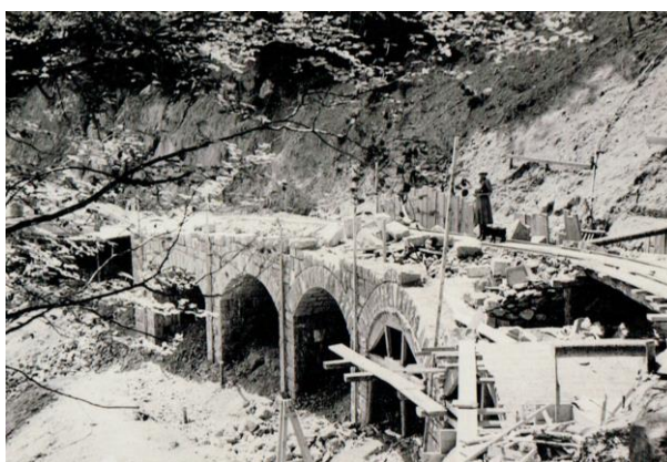
Bau Sattelleggstrasse: Viadukt Schlipf, zwischen Vorderthal SZ und Passhöhe, nach der 2. Wendeplatte (Bild: Privatarchiv Fridolin Mächler-Mazenauer)
