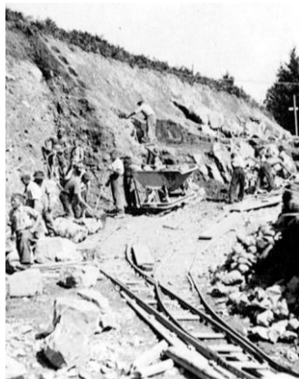
Bau Sattelleggstrasse: Hangsicherung vor der 6. Wendeplatte (Bild: Privatarchiv Fridolin Mächler-Mazenauer)
