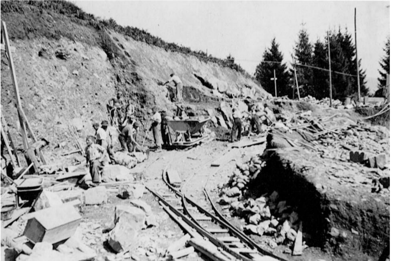
Bau der Sattelleggstrasse (1940-1942): Hangsicherung vor der sechsten Wendeplatte (Bild: Privatarhiv Fridolin Mächler-Mazenauer, Wangen)
